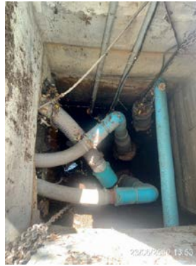
เครื่องสูบน้ำสำหรับระบายน้ำสู่ท่อระบายสาธารณะด้านข้าง โครงการ
