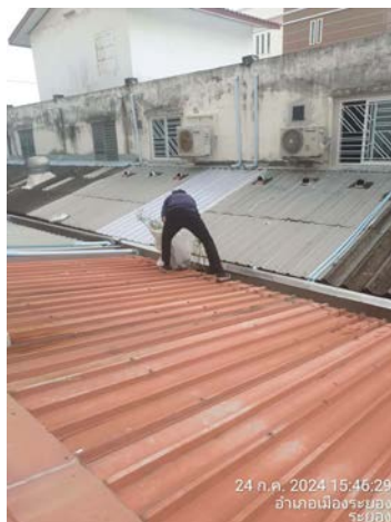
รูปที่ 2-23 เจ้าหน้าที่ตรวจสอบและทำความสะอาดรางระบายน้ำ
