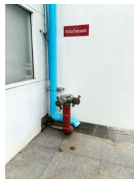
หัวรับน้ำดับเพลิง บริเวณอาคาร B และอาคารหอพักแพทย์
