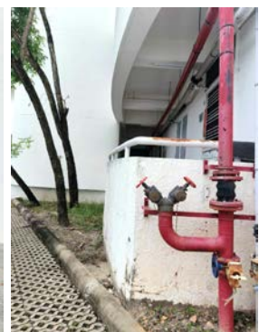
หัวรับน้ำดับเพลิง บริเวณอาคาร B และอาคารหอพักแพทย์
