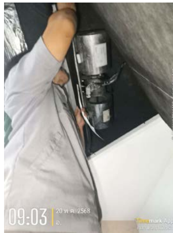
รูปที่ 2-8 เจ้าหน้าที่ล้างทำความสะอาด และ ซ่อมแซมเครื่องปรับอากาศ และระบบระบายอากาศ
