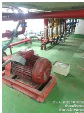
ระบบปั๊บน้ำดับเพลิง
