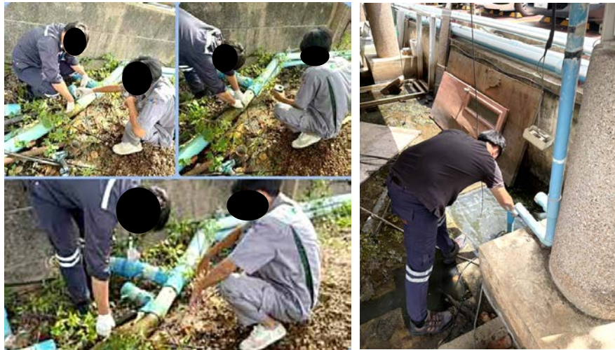
รูปที่ 2-19 การตรวจสอบและซ่อมแซมท่อน้ำประปาที่ชำรุด
