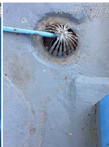
รูปที่ 2-23 เจ้าหน้าที่ตรวจสอบและทำความสะอาดรางระบายน้ำ
